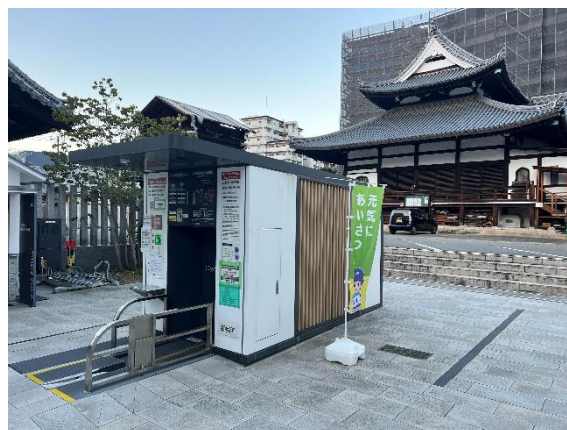
写真5 地下式駐輪場の事例（兵庫県伊丹市）
