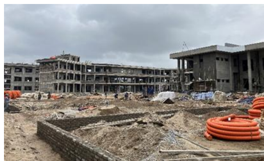
写真 5.新キャンパス工事風景(2024.2)
