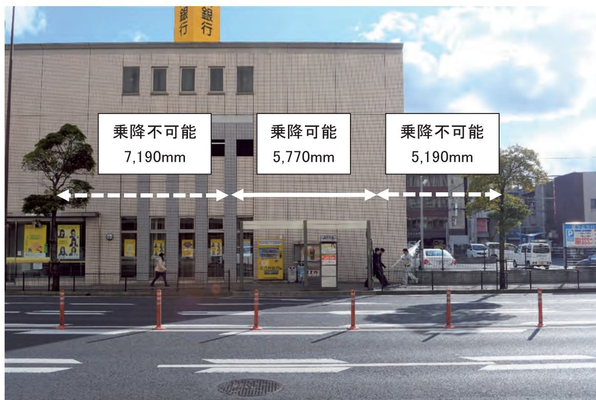
図 13 既存の防護柵が障害となっているバス停の事例
