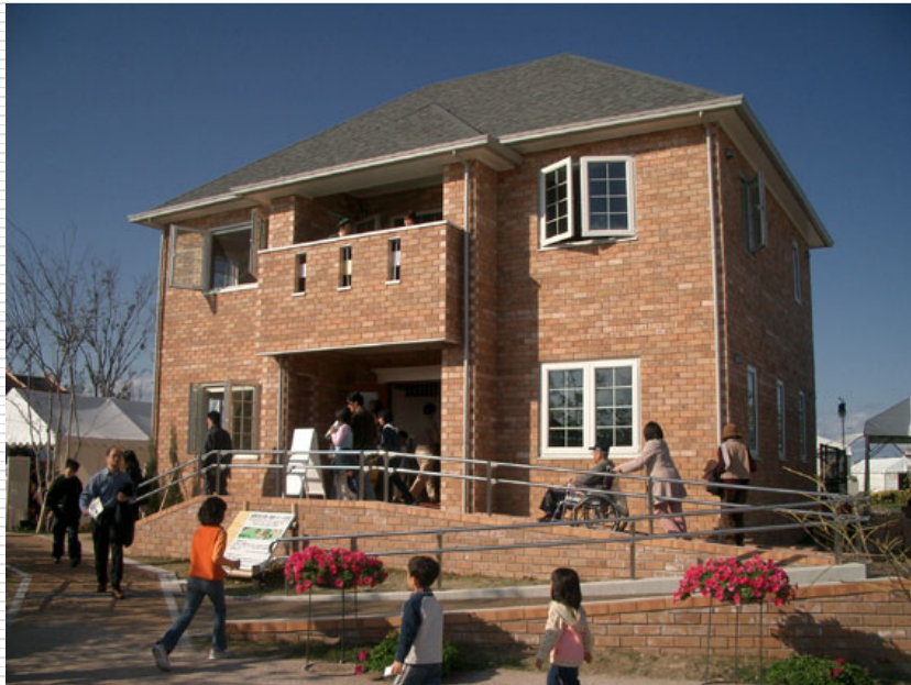
乾式煉瓦造住宅
