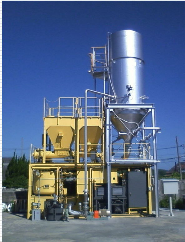
プロジェクトで改質フライ アッシュプラントを建設
