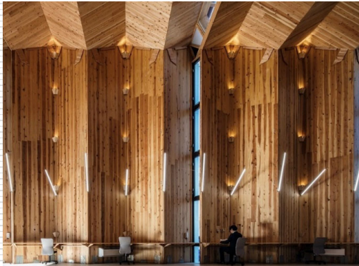
国産杉CLTによる折板構造建築
