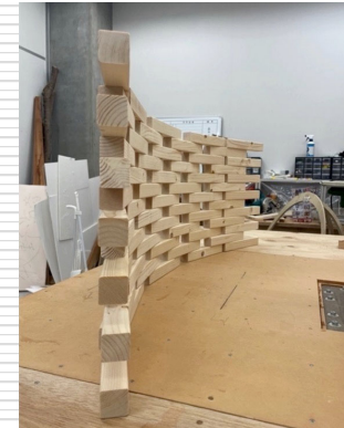
アーム型ロボットによる積層木造ドーム
