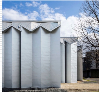
国産杉CLTによる折板構造建築
